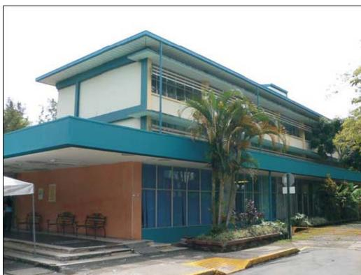
Construcción cubierta del bloque sur de la Facultad, para dar protección a las losas de concreto existentes y evitar las filtraciones de agua al edificio.
