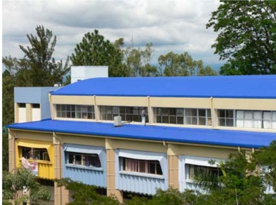
Se sustituye el techo existente por una cubierta de estructura abovedada en el centro, con dos cubiertas de una sola agua en los extremos. Se utilizan láminas completas sin traslapes.
