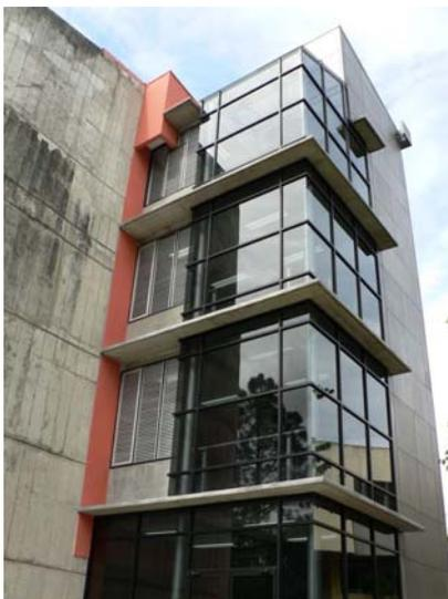
Este proyecto consiste en la construcción de un ducto elevador – equipo marca Thyssen Krupp- de 4 niveles, de estructura metálica y forro de láminas moduladas de fibrocemento, con vestíbulos en cada piso y cierre de vidrio y aluminio.
