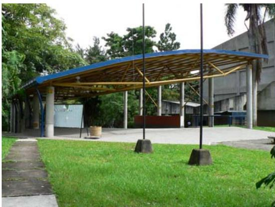
Cubierta soportada en columnas de concreto y estructura metálica para el anfiteatro. Tiene como objetivo impulsar el aprovechamiento de este sitio en actividades diversas.
